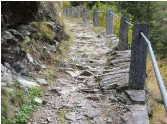
*Immagine 56: Caratteristica tipica del sentiero con muri di sostegno a valle e parapetto sulla sponda boschiva ripida*
